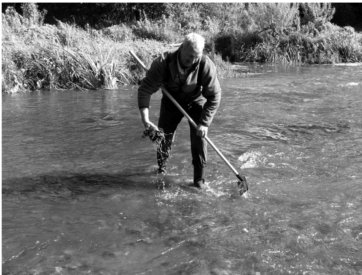
5. attēls. Pēc gultnes mehāniskās iridnāšanas ar grābekli tiek izcelti atsevišķie saglabājušies sakņu sakopojumi. Fonā ūdensaugiem pāraudzis, vēl neirdināts upes posms.
